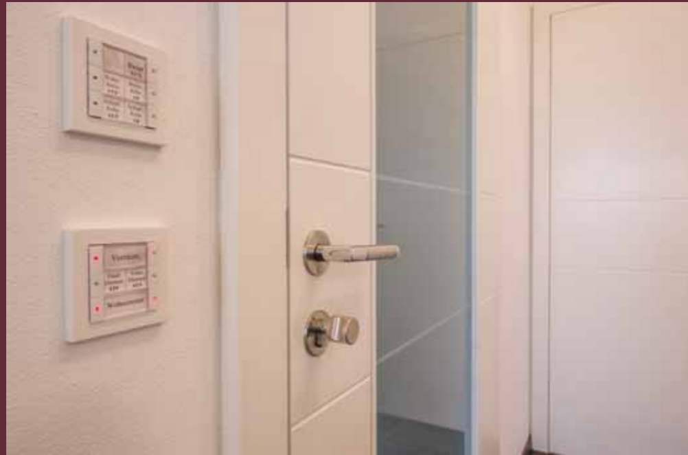
Detail flächenbündige Glasleiste und stumpf einschlagend
