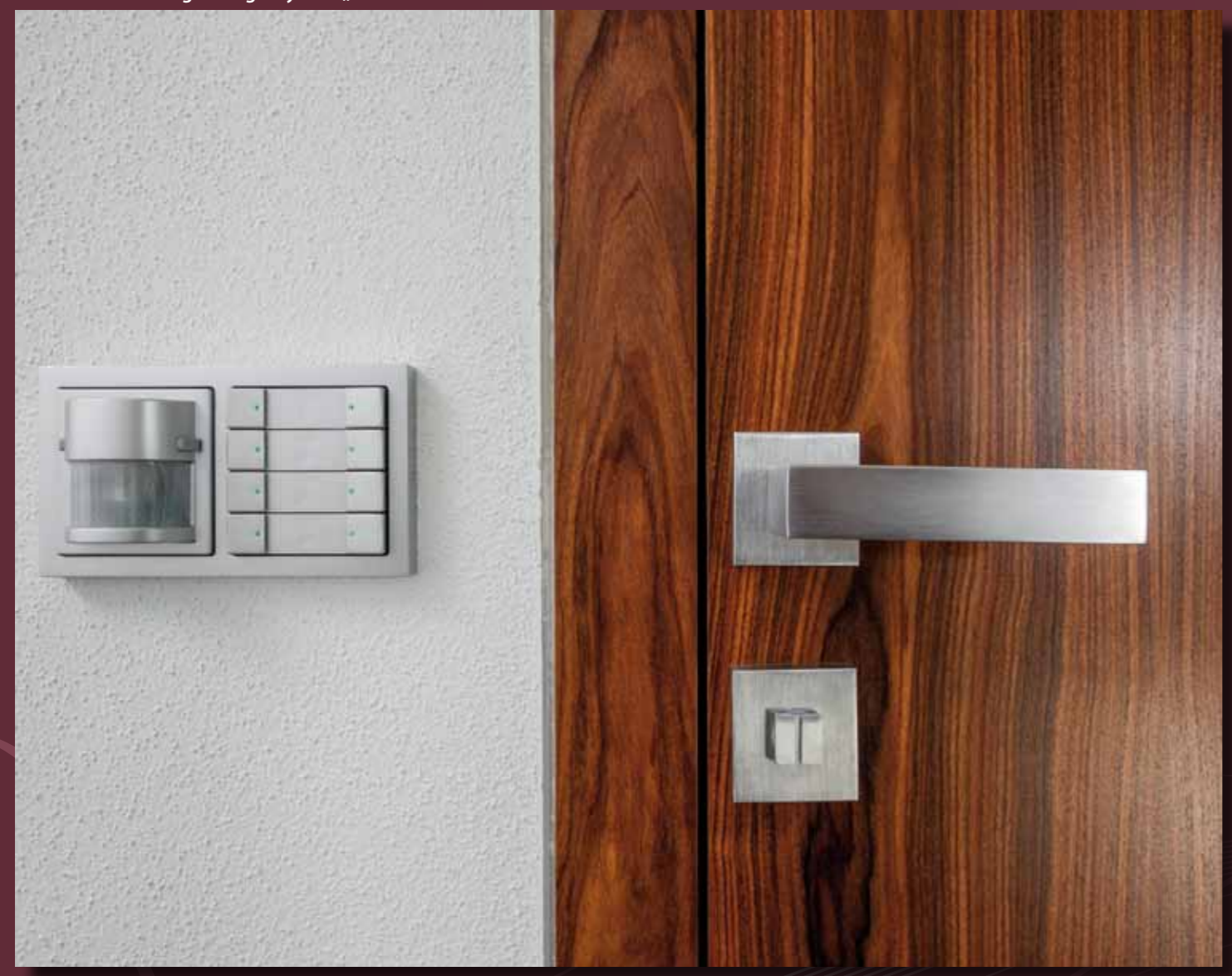
Detail mauerbündiges Zargensystem „Slim“
